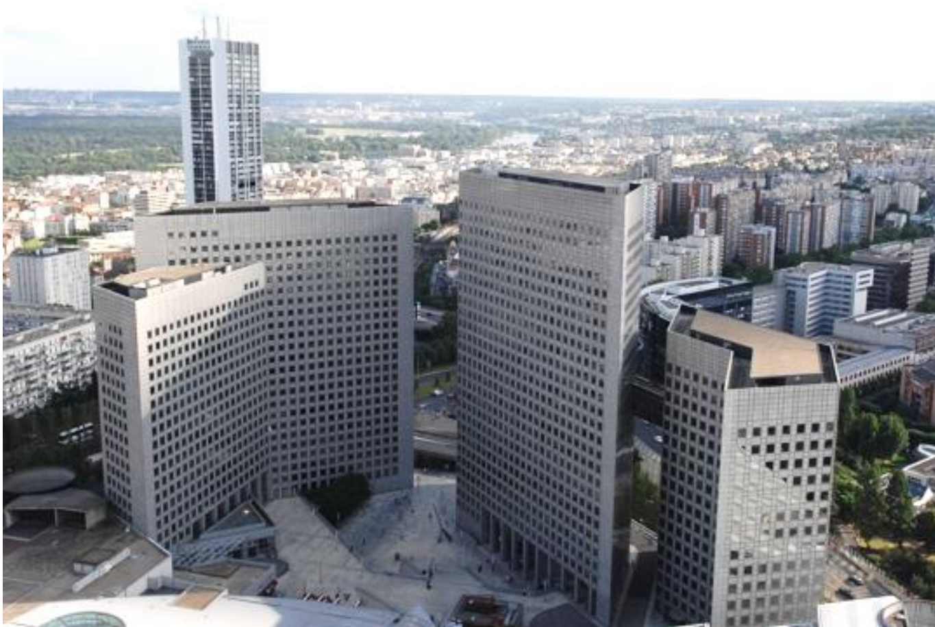
● ● TOUR VOLTAIRE Réalisation: 2016 Localisation: La Défense, 92
